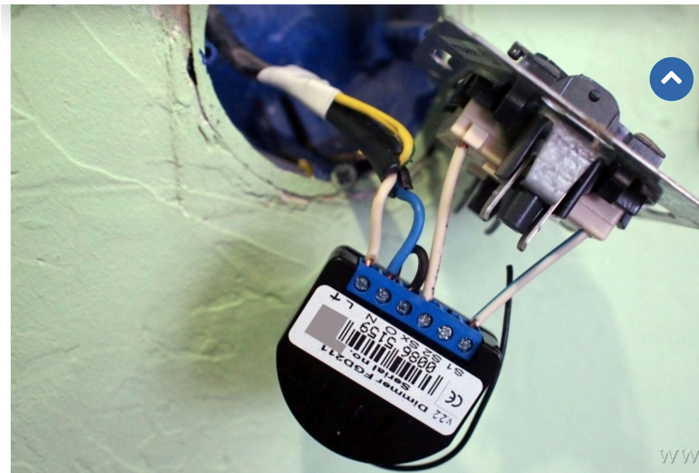
Рис. 29. Подключенный к выключателю диммер Fibaro FGD-211
